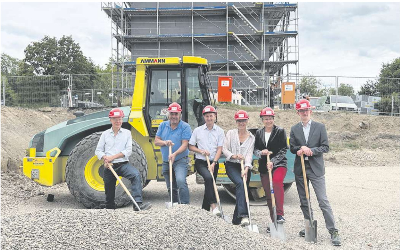
Spatenstich mit (v.l.) Daniel Spies (foundation 5+ architekten BDA), Martin Rode (Bauingenieur Ernst Rode Bau), Dirk Losse (geschäftsführender Gesellschafter Planungsgruppe Wagener GmbH), Susanne Arndt (Architektin und Leiterin der technischen Abteilung SWB), Petra Broistedt (Oberbürgermeisterin Stadt Göttingen) und Christian Schmelcher (Geschäftsführer SWB). Foto: SWB
